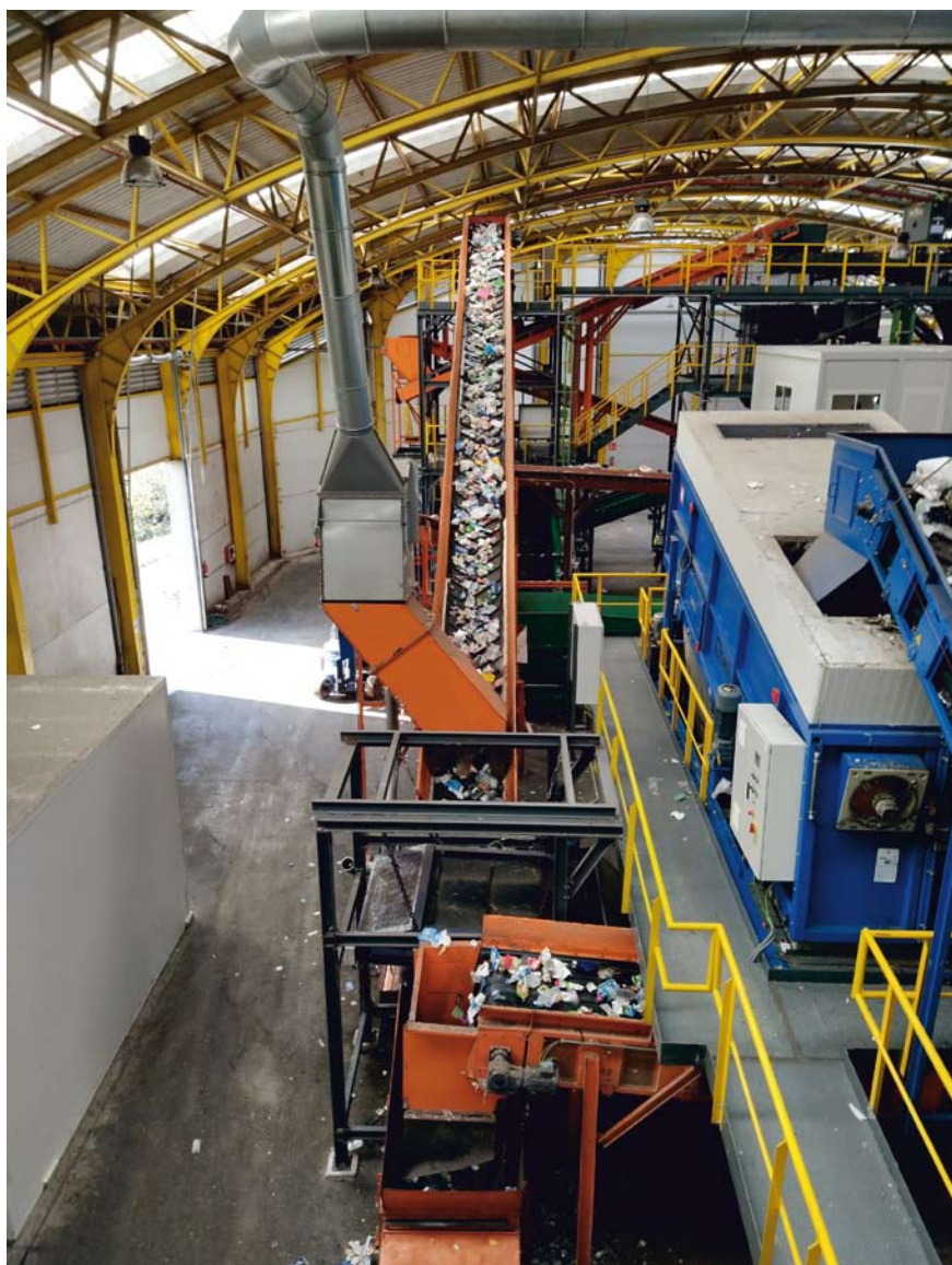
Photos: Calaf Constructura / Sorton
