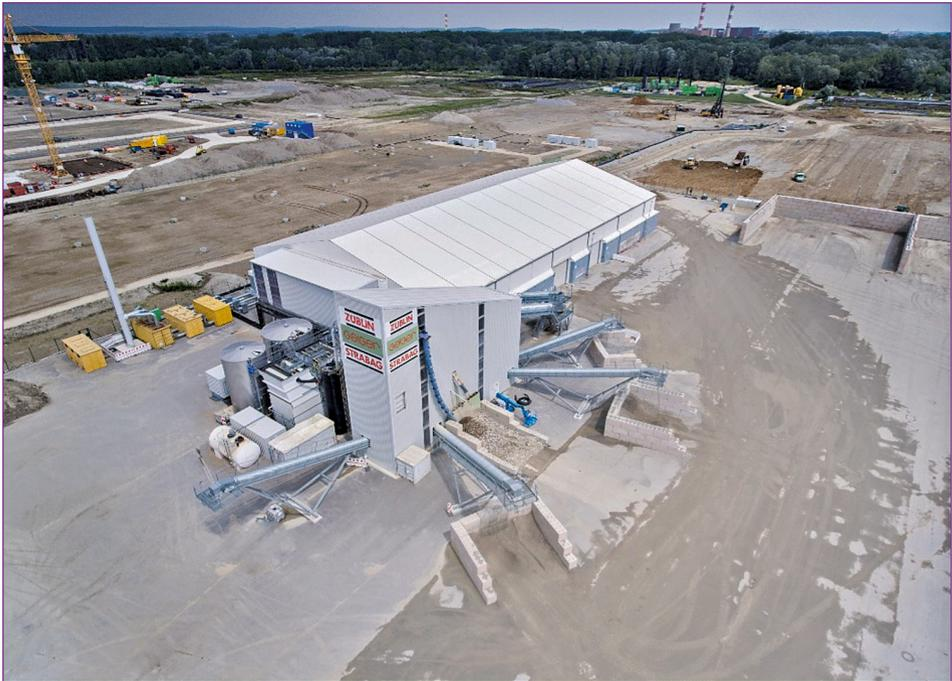
Bild 1: Bodenwaschanlage zur Sanierung des Geländes einer ehemaligen Ö Raffinerie in Süddeutschland
